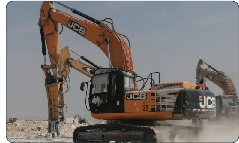
حفارة جاك هامر Excavator Jack Hummer
